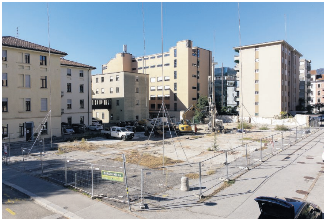
L'area dove sorgerà il nuovo stabile
